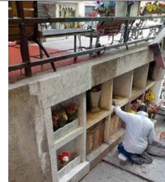
Apoyo en Pabellón N°50
